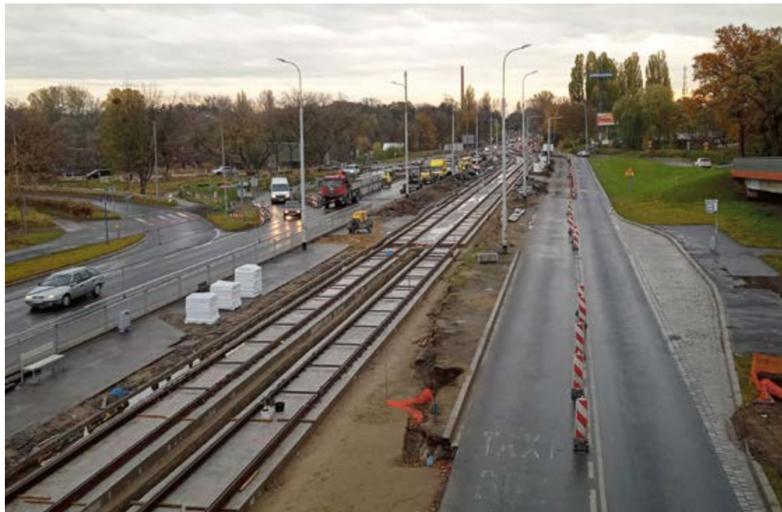
Trwają prace przy betonowaniu nowego torowiska, dzięki temu wjadą na nie też autobusy MPK
